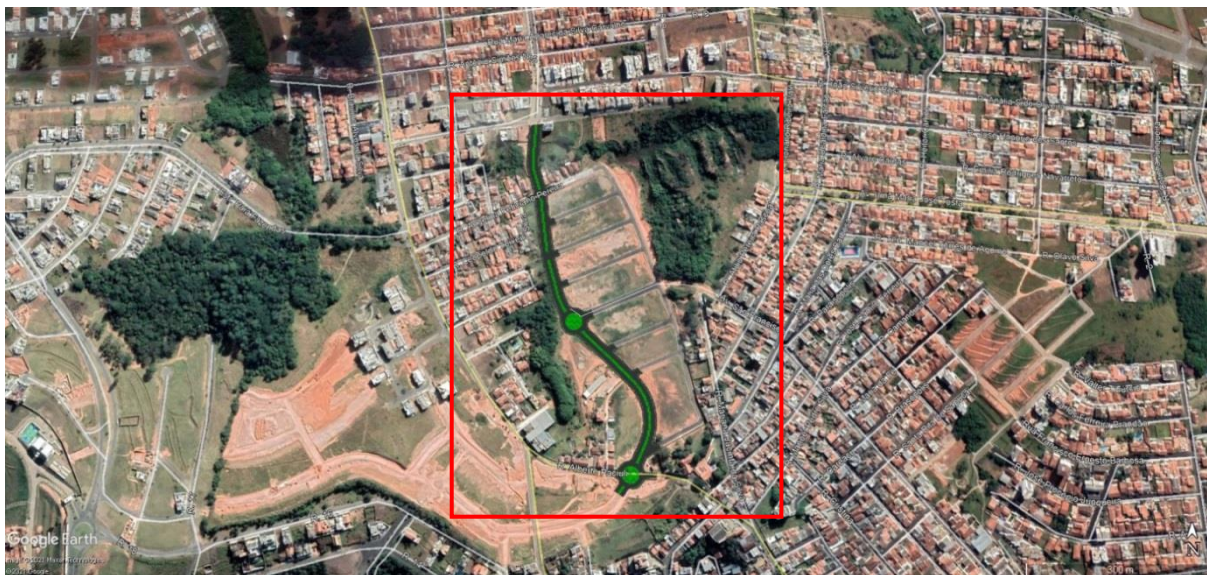
Figura 1 – Área de Abrangência do Projeto – Obras de drenagem e pavimentação da via de interligação entre a via Noroeste e a Rua Alberto Paciulli
